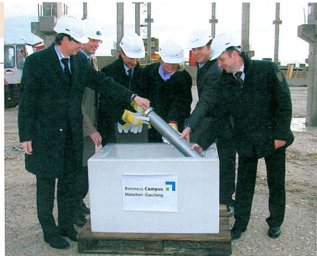
Grundsteinlegung für das Nahversorgungszentrum des Business Campus direkt an der B471 (von links nach rechts): Christian Bretthauer (Zentralgeschäftsführung der Unternehmensgruppe Dr. Vielberth), Josef Peindl (Bereichsleiter für Hoch- und Tiefbau Karl Bachl GmbH & Co. KG), Dr. Lothar Koniarski (Zentralgeschäftsführung der Unternehmensgruppe Dr. Vielberth und Geschäftsführer und in dieser Eigenschaft auch Geschäftsführer der Gewerbeplan GmbH), Hannelore Gabor (Erste Bürgermeisterin der Stadt Garching), Florian Hahn (MdB) und Michael Blaschek (Geschäftsführung Business Campus Management GmbH).
