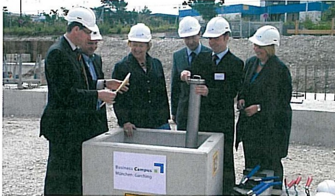
Grundsteinlegung für das fünfte Gebäude im Business Campus (v.l.n.r.): Christian Bretthauer (Vielberth AG), Bernhard Hanis (Berger Bau, Passau), Johanna Rumschöttel (Landrätin), Dr. Lothar Koniarski (Geschäftsführer Vielberth AG), Michael Blaschek (Geschäftsführer Business Campus) und Hannelore Gabor (Bürgermeisterin).
