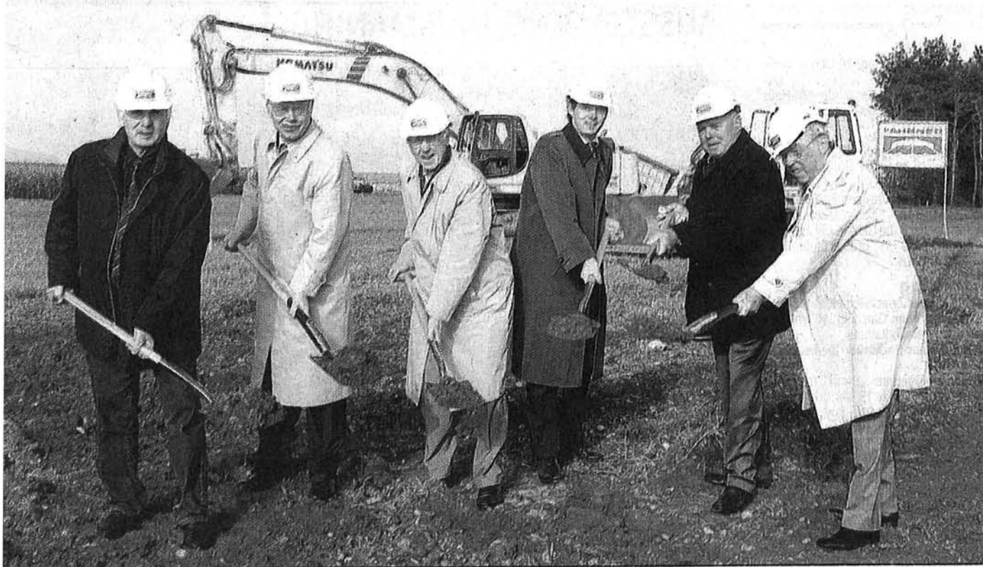
Auf gutes Gelingen: (v. l.) Karlheinz Gärtner (Straßenbauamt), Thomas Klingelhöfer (Vielberth), Bürgermeister Manfred Solbrig, Geschäftsführer Christian Bretthauer, Betriebsleiter Robert Fahrner und Alt-Bürgermeister Helmut Karl. Foto: Förtsch
