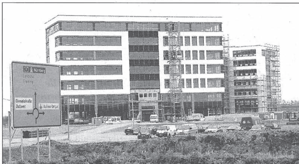
Das erste Bürohaus des Business-Campus in Garching.
