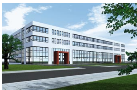
Atriumhaus Parking 15-17. Baubeginn: Frühjahr 2009
